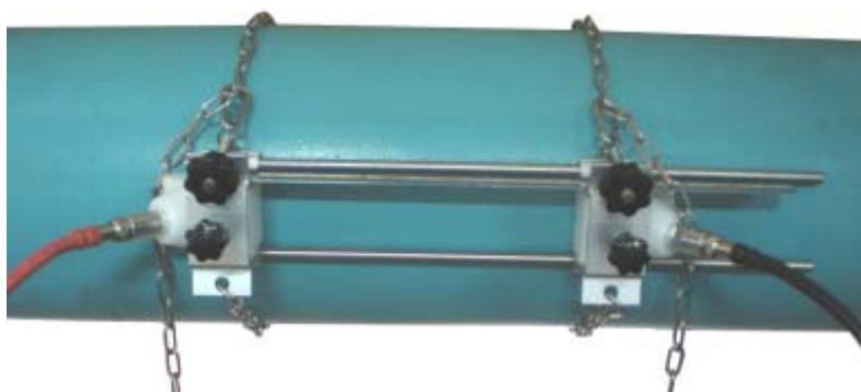
Установка монтажной рамы для портативного расходомера (Задний план)
